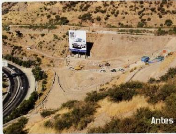
Túnel San Cristóbal
